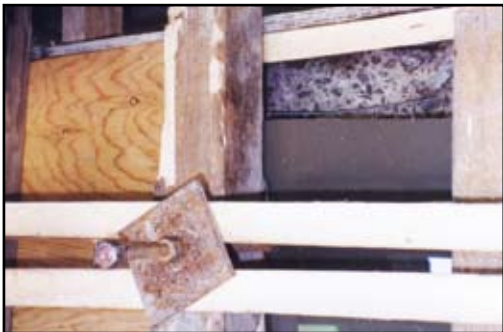
Autoroute 40/540, Québec City, Québec Canada. Réparation d'une poutre de soutien vu à travers une forme en plexiglass. Aucune vibration interne n'a été faite. AMBEX-SCC coule sans restriction, par gravité, dans le coffrage de 11 mètres (35 pieds).
