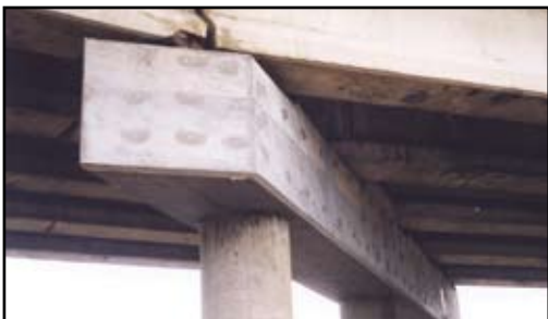
Autoroute 40/540, Québec City, Québec, Canada. Réparation finie de la poutre de soutien.
